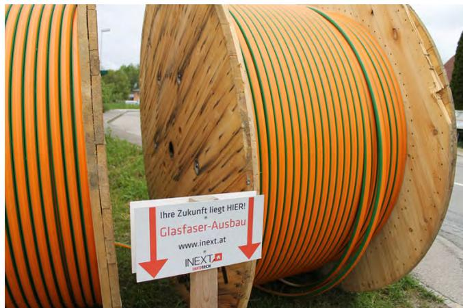
Weiters haben wir beschlossen dass beim Ausbau der Glasfaser, in den Bereichen, wo es Sinn macht, ein Leerrohr **für die Straßenbeleuchtung** mitverlegt wird. Dadurch haben wir die Möglichkeit, bei Schäden das alte Kabel einfach auszutauschen! Des weiteren werden wir im Zuge des Glasfaserausbaues die zugesagten **Straßenbeleuchtungserweiterungen** in Stegmühl und Herbstheim zur Umsetzung bringen!
